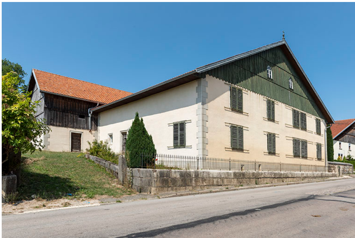
Façades postérieure et latérale gauche.
