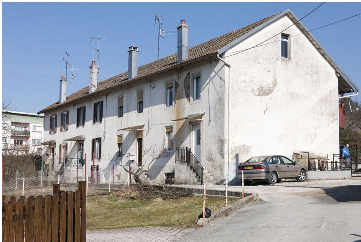
Habitation à 8 logements (?) rue du Nègre.
