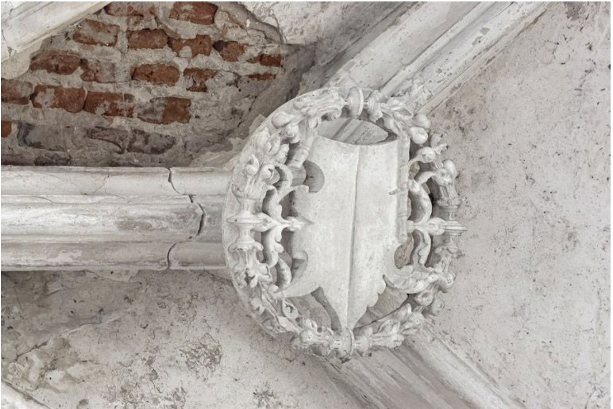
Intérieur de la chapelle : clef de voûtes.
