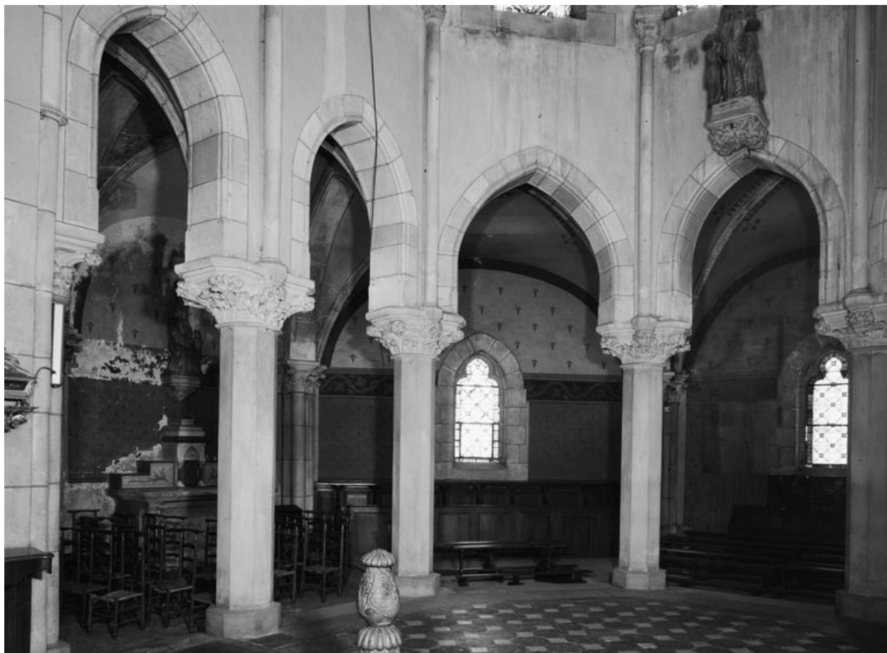
Vue du rond-point du choeur.
