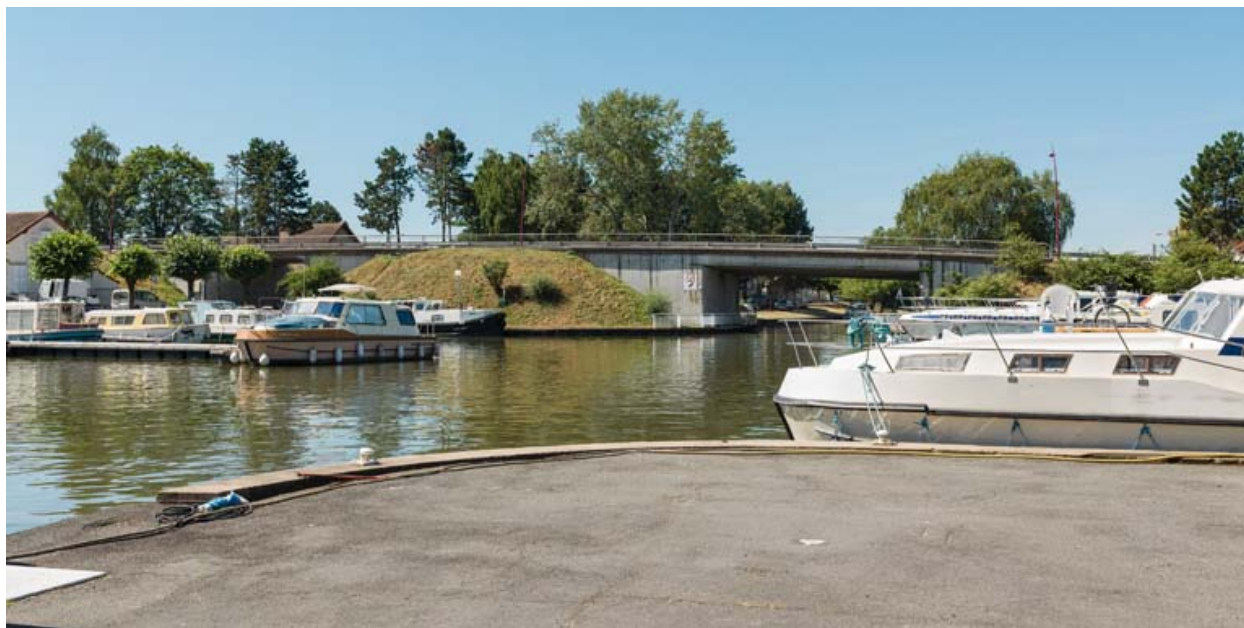
Vue générale du site et du pont.
