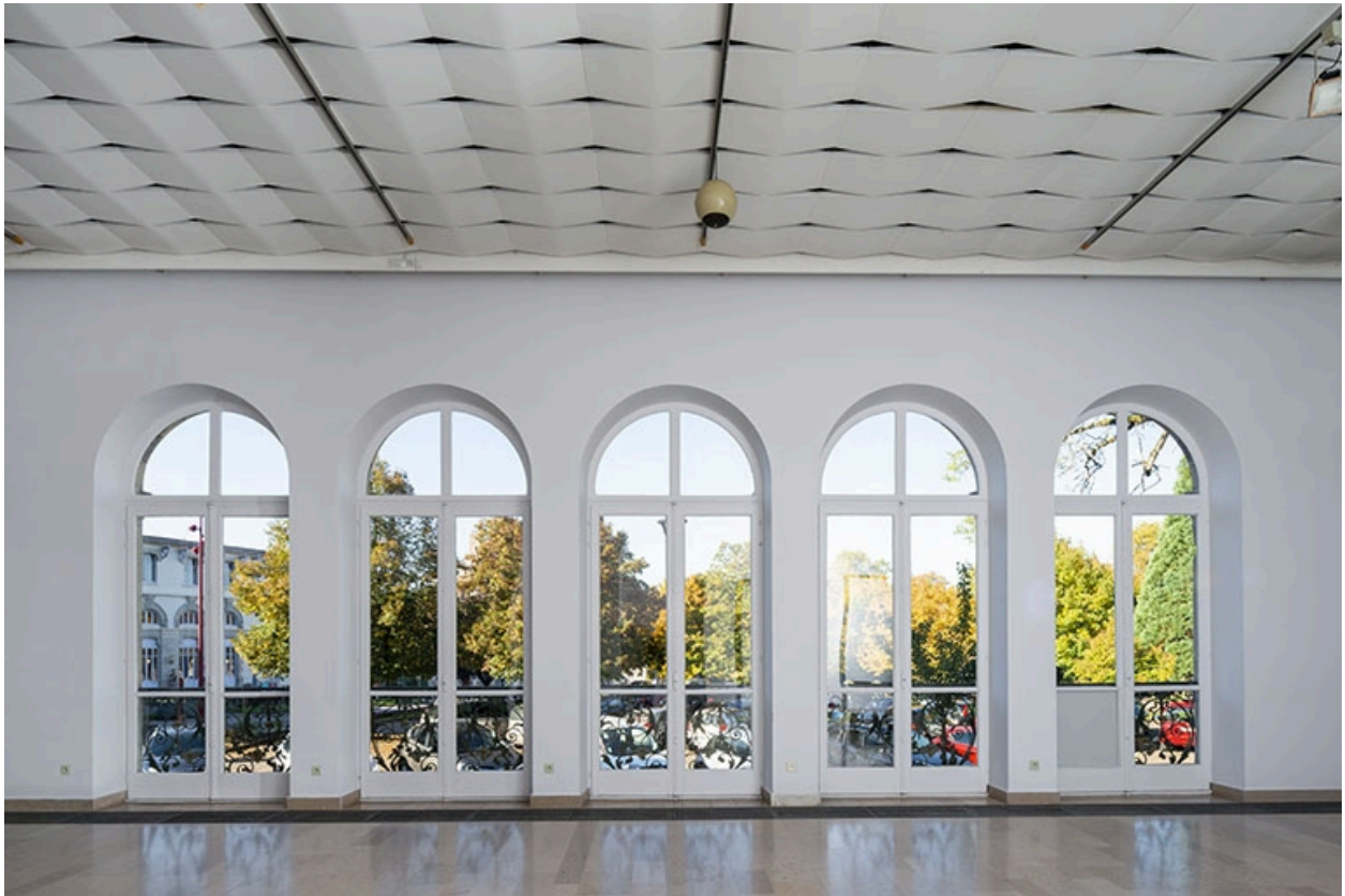
Galerie, vue en direction de l'ouest.
