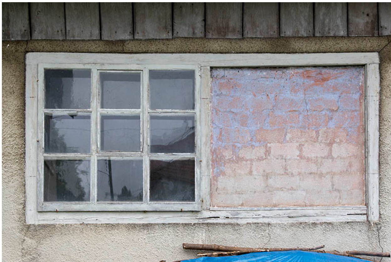
Façade latérale droite : fenêtres.
