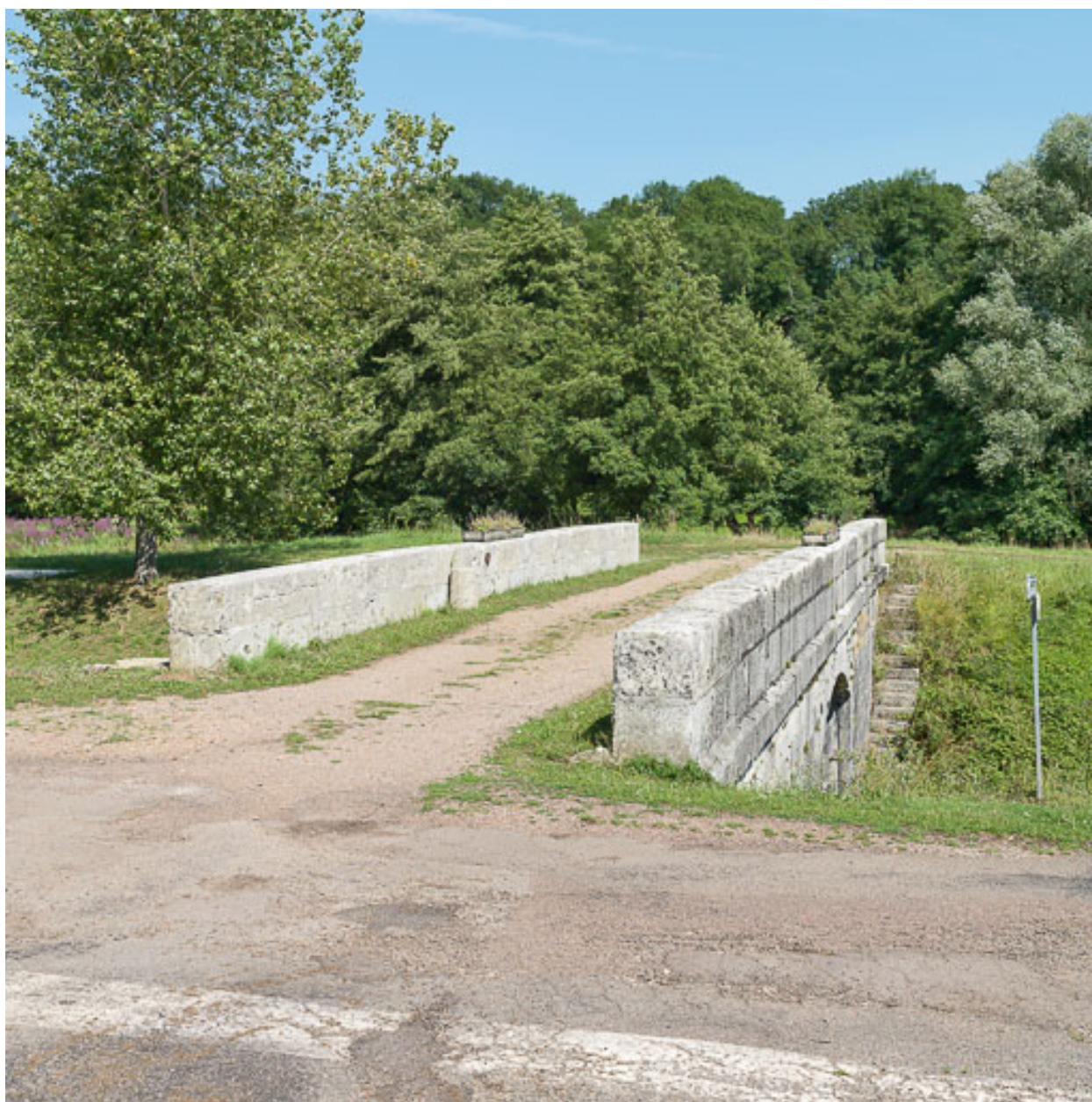
Vue du pont.
