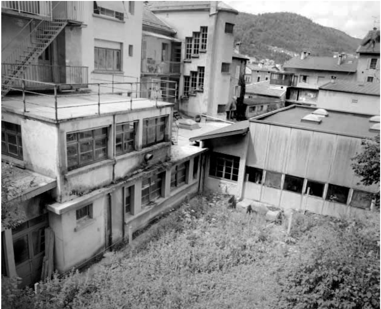
Ateliers de fabrication. Atelier de 1967 à droite.
