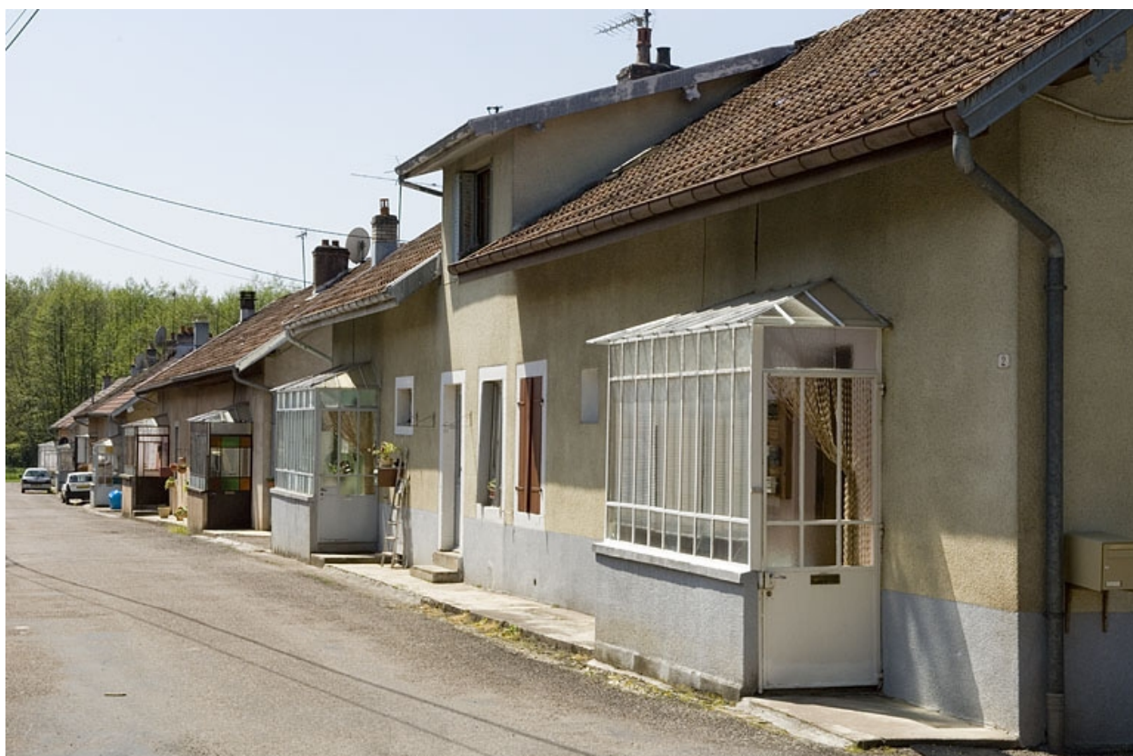
Alignement de façades de la cité ouvrière.
