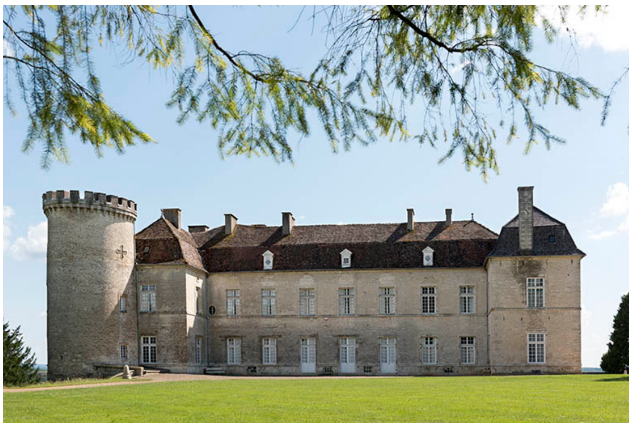
Vue générale de la façade nord.
