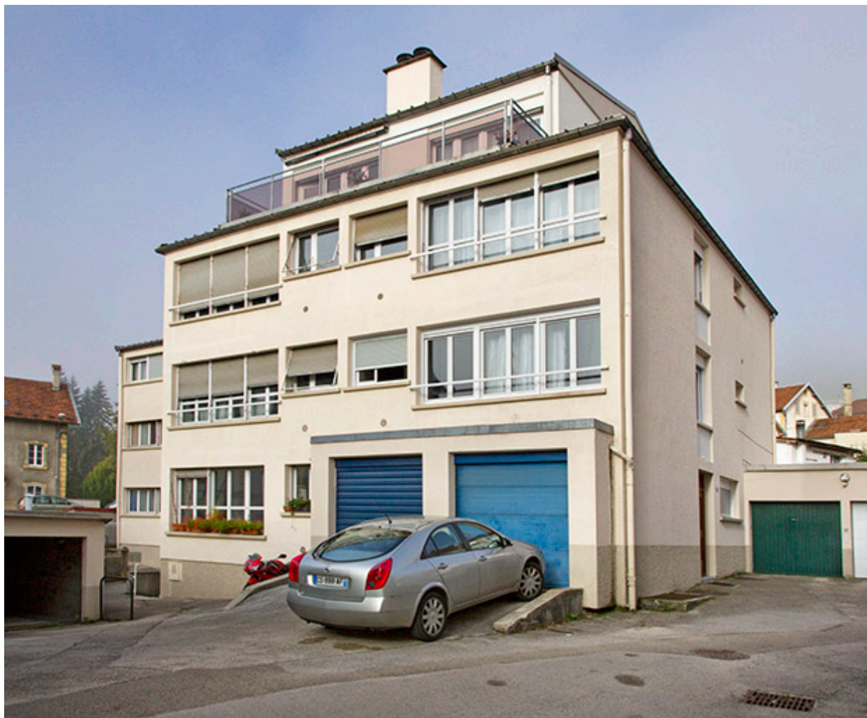
Bâtiment sud : façades antérieure et latérale droite.
