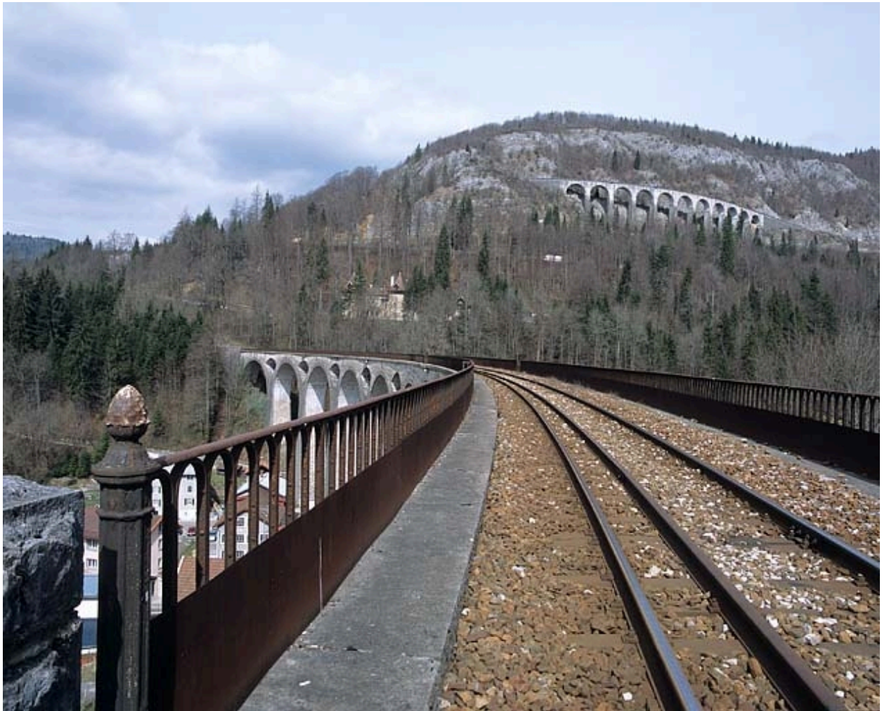
Tablier et garde-corps métallique côté Andelot-en-Montagne.
