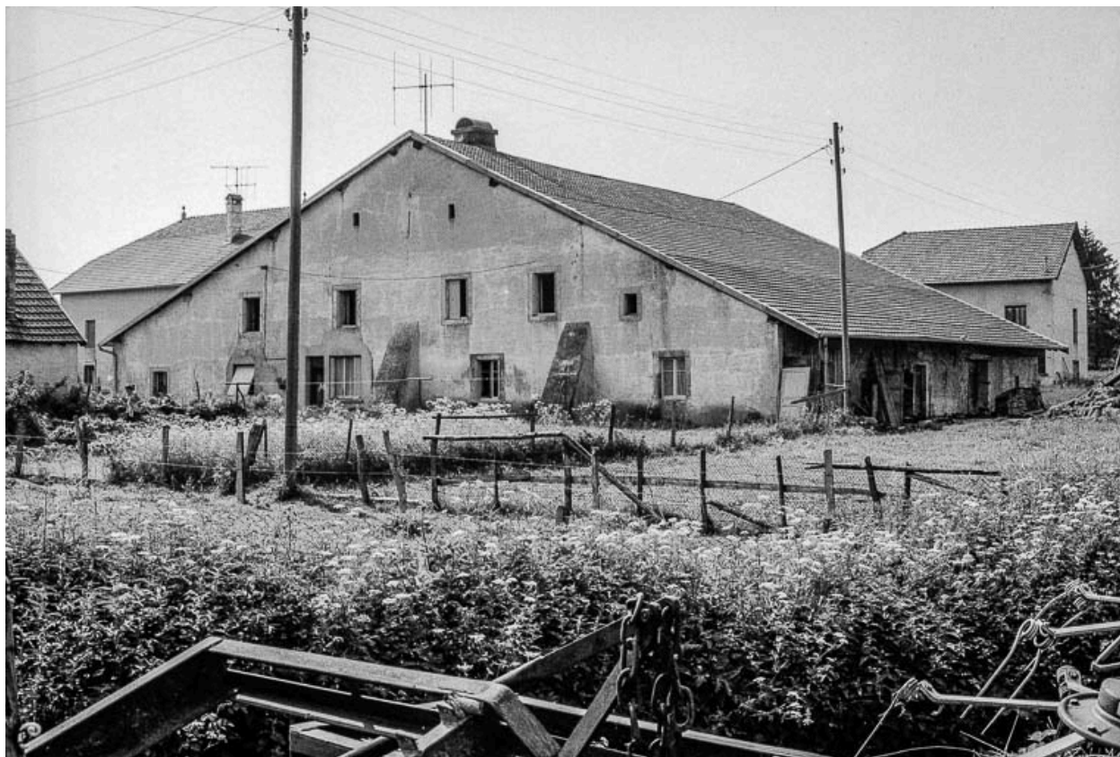
Ferme datée de 1750, cadastrée 1938 F 56 : façade antérieure.
