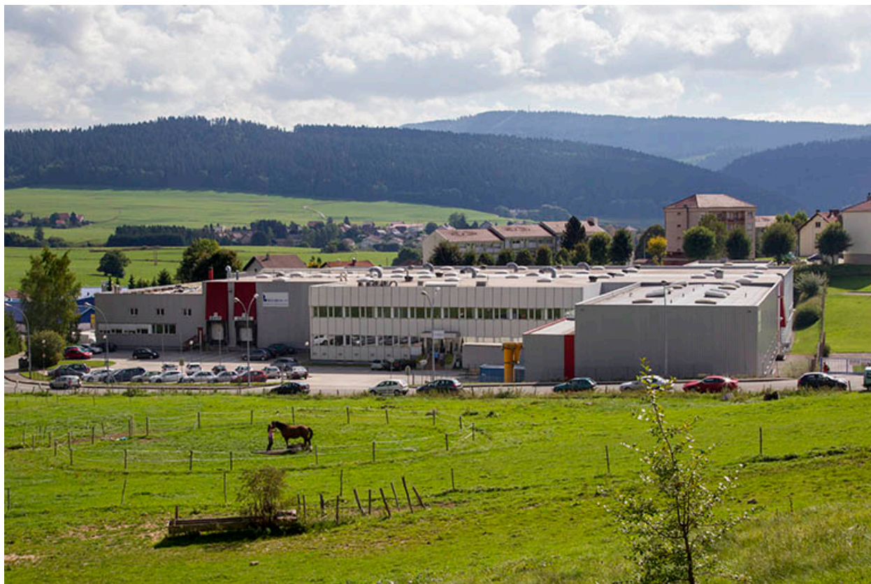
Fonderie et usine de pièces détachées en matière plastique Bourbon, à Morteau.
