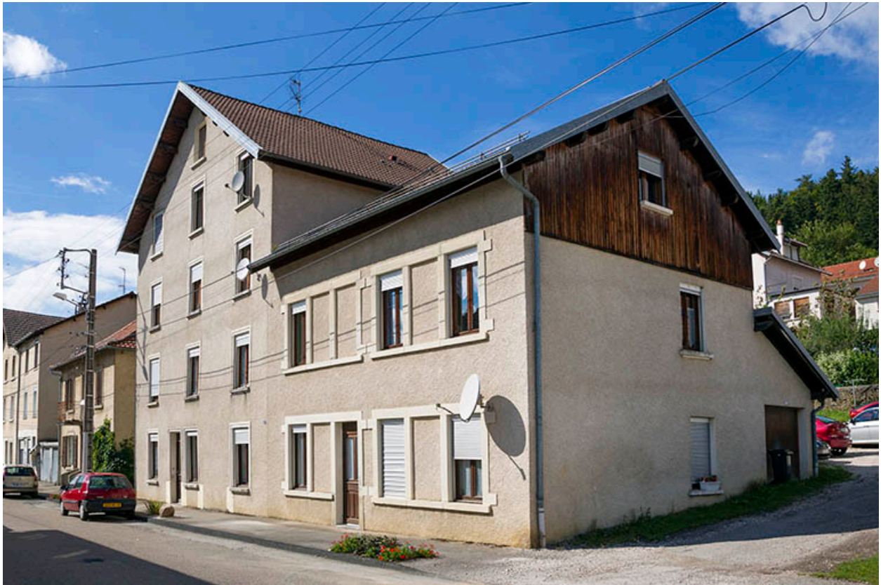
Façades antérieure et latérale droite.
