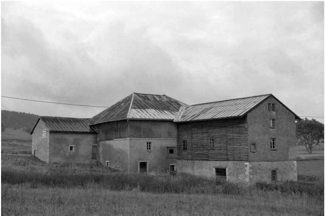
Vue d'ensemble depuis le nord (façades postérieures).
