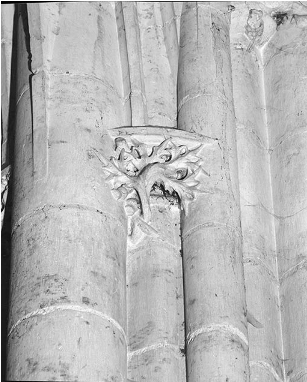
Collatéral droit, 3e travée, pilier postérieur gauche : détail du culot inférieur.
