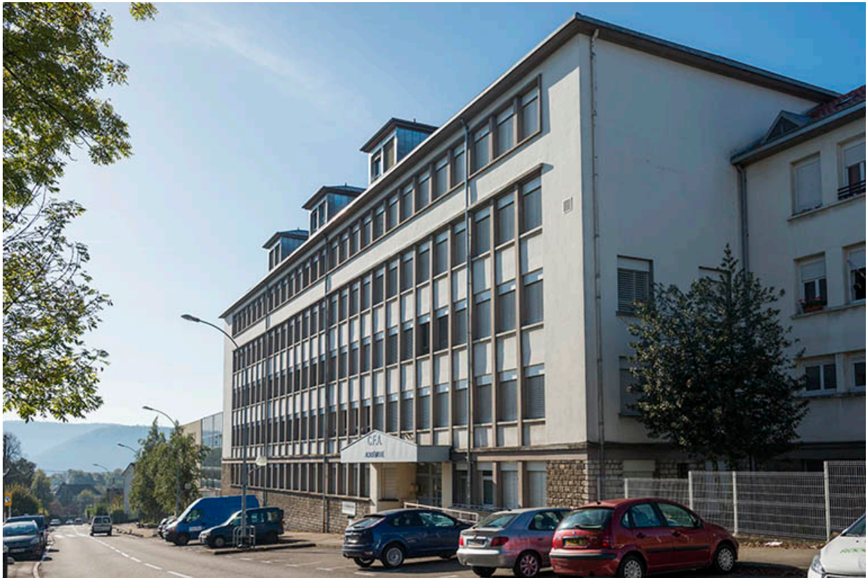
Entrée du Centre de formation des apprentis le long de l'avenue du commandant Marceau.
