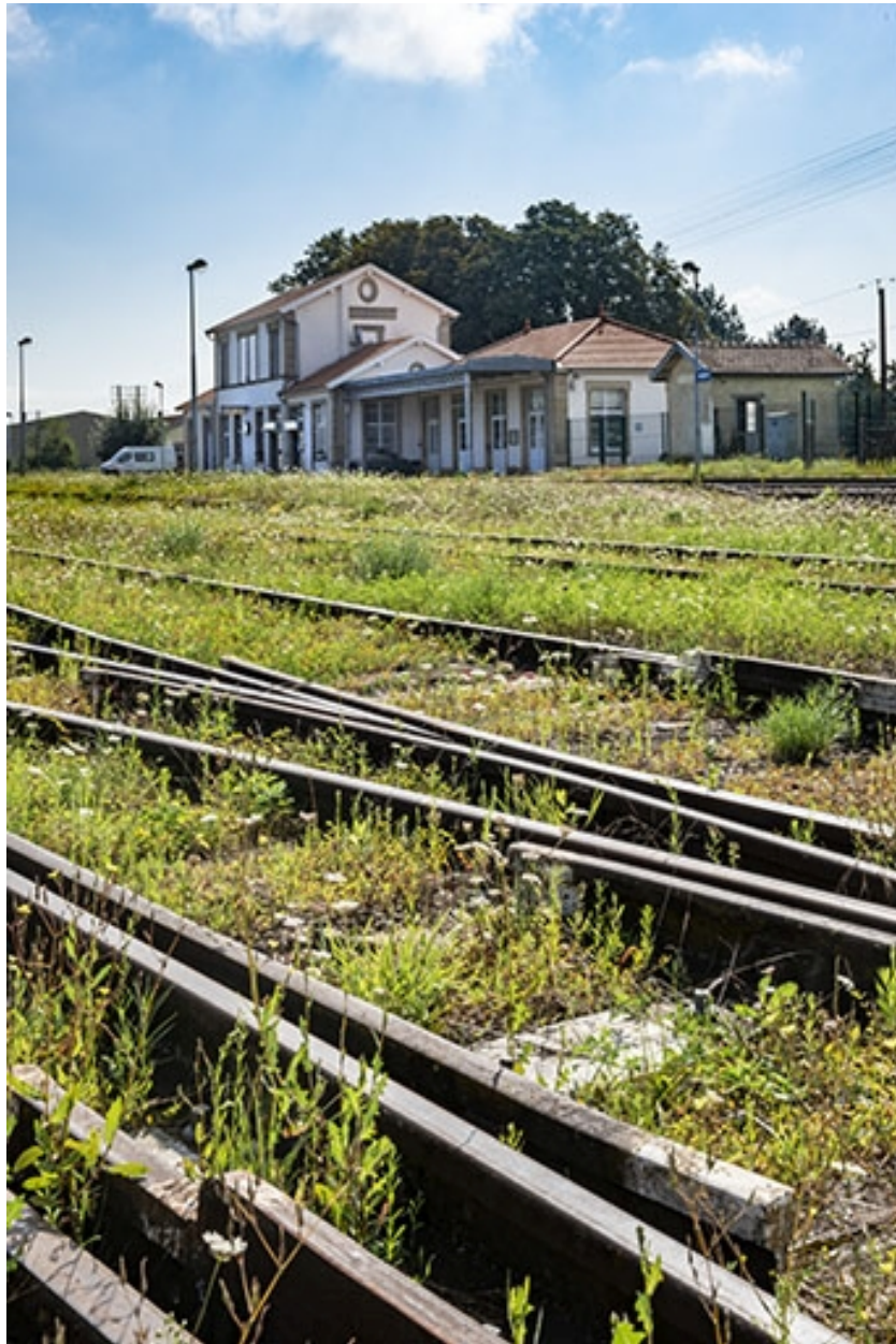
La gare, vue éloignée depuis les voies.
