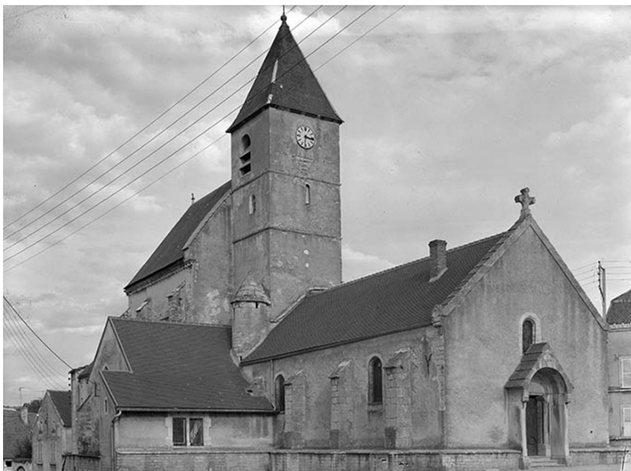
Façade occidentale, bas-côté et transept nord.
