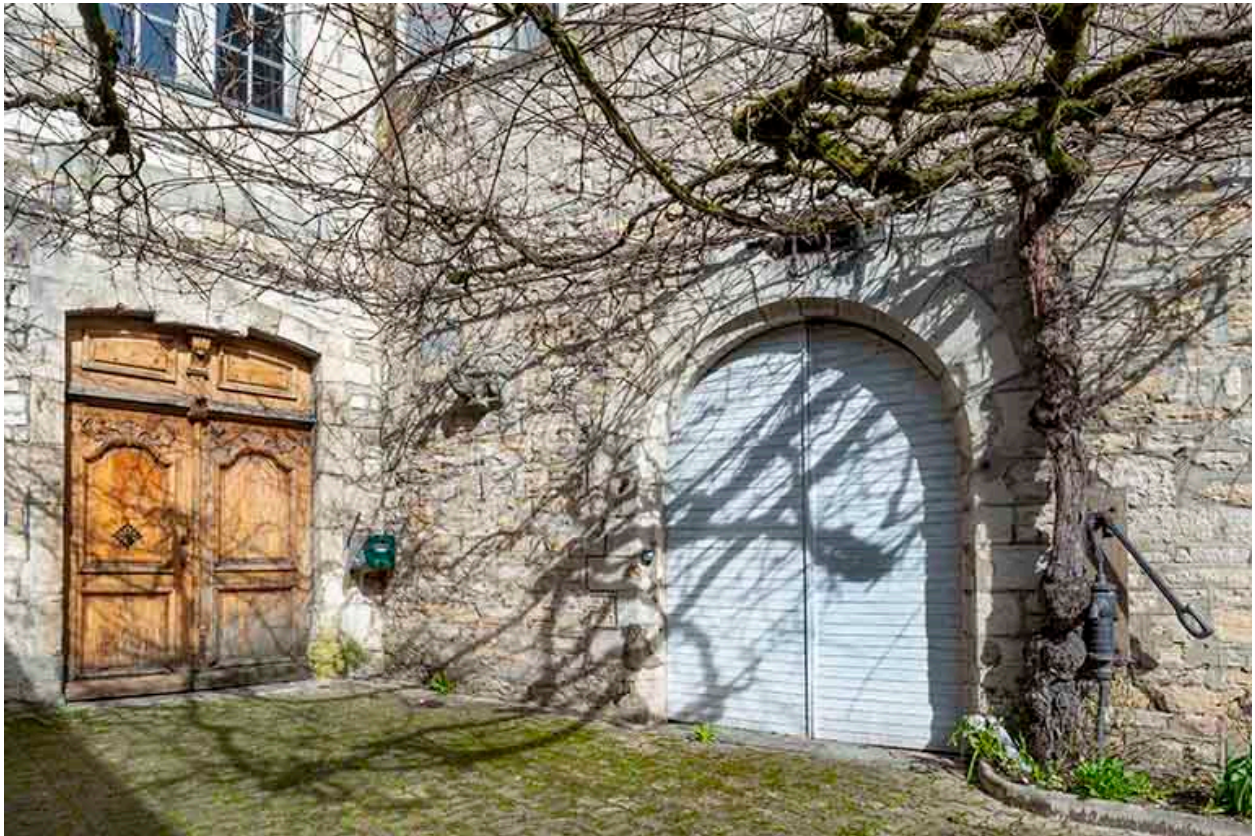
Portes sur la cour.
