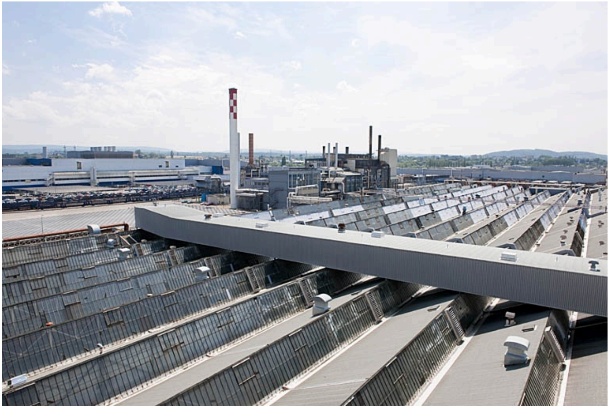
Vue d'ensemble depuis l'est : atelier de ferrage et centrale thermique (cadrage vertical).
