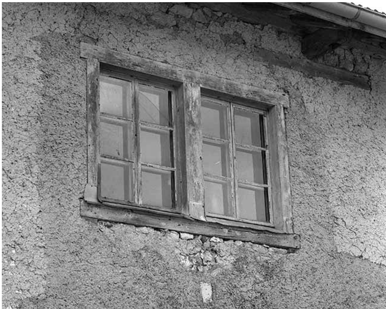
Fenêtre double sur la façade postérieure.
