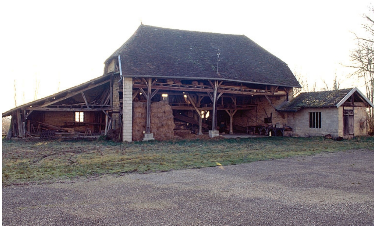
Scierie depuis le nord-ouest.
