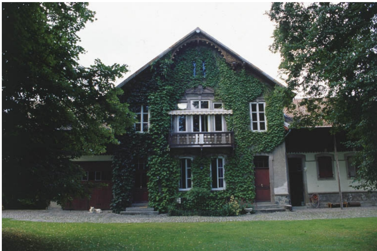
Mur-pignon du logement de la ferme.
