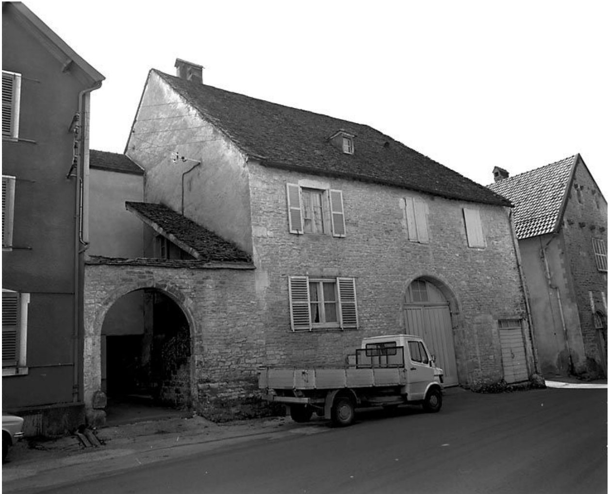
Maison située 8 rue Edouard Bastide.
