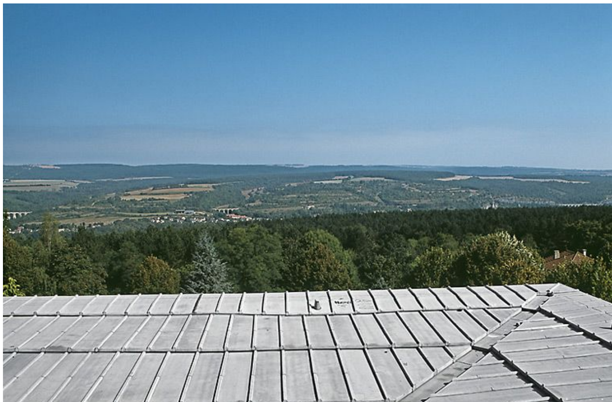
Toiture de l'aile ouest et site.
