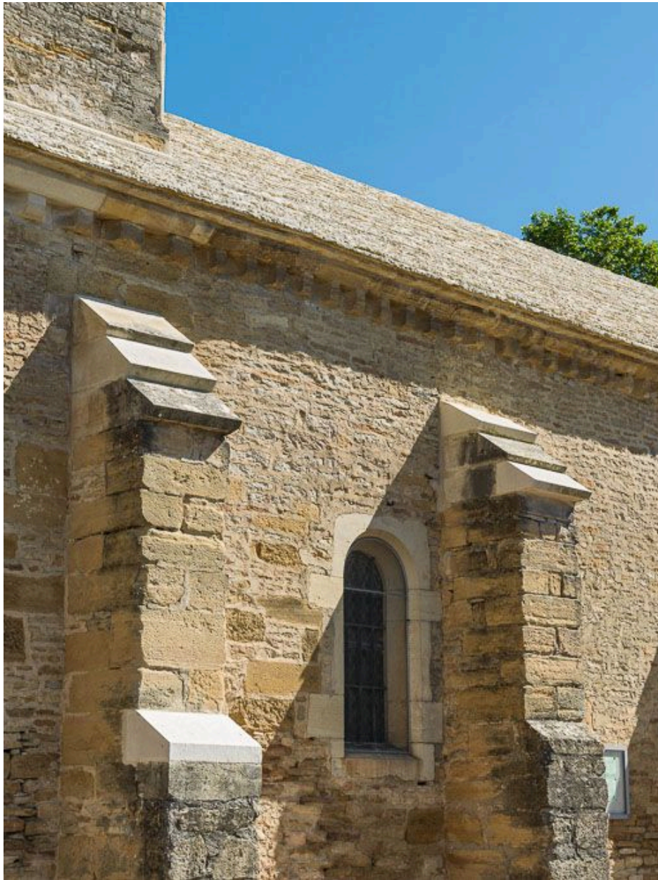
Elévation sud-ouest, détail de la travée.
