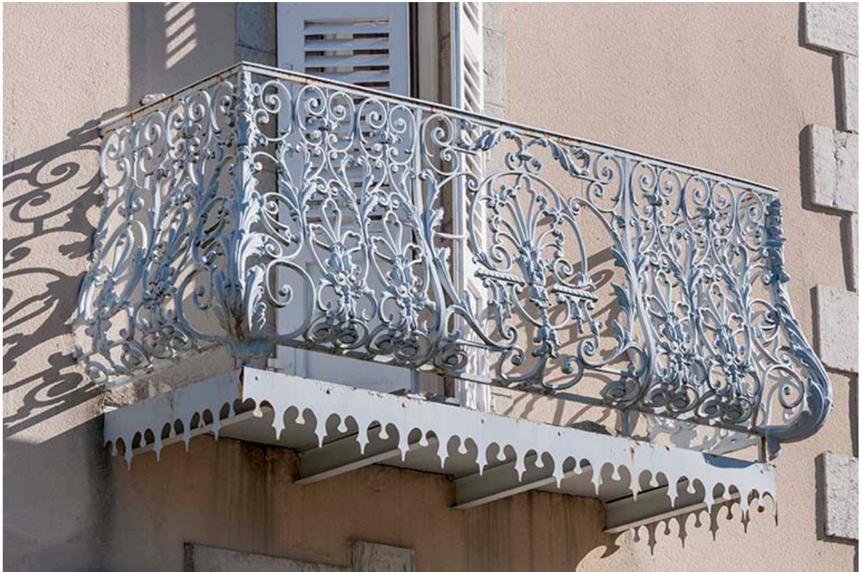
Logement patronal : balcon métallique sur la façade antérieure.
