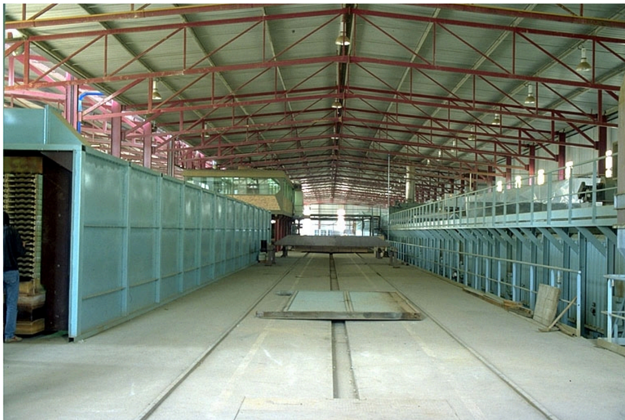
Briqueterie et tuilerie Emile Jacob, Commenailles : tunnel sécheur à gauche et four à bassin à droite.
