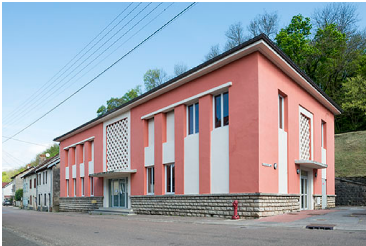
Vue générale de l'édifice.
