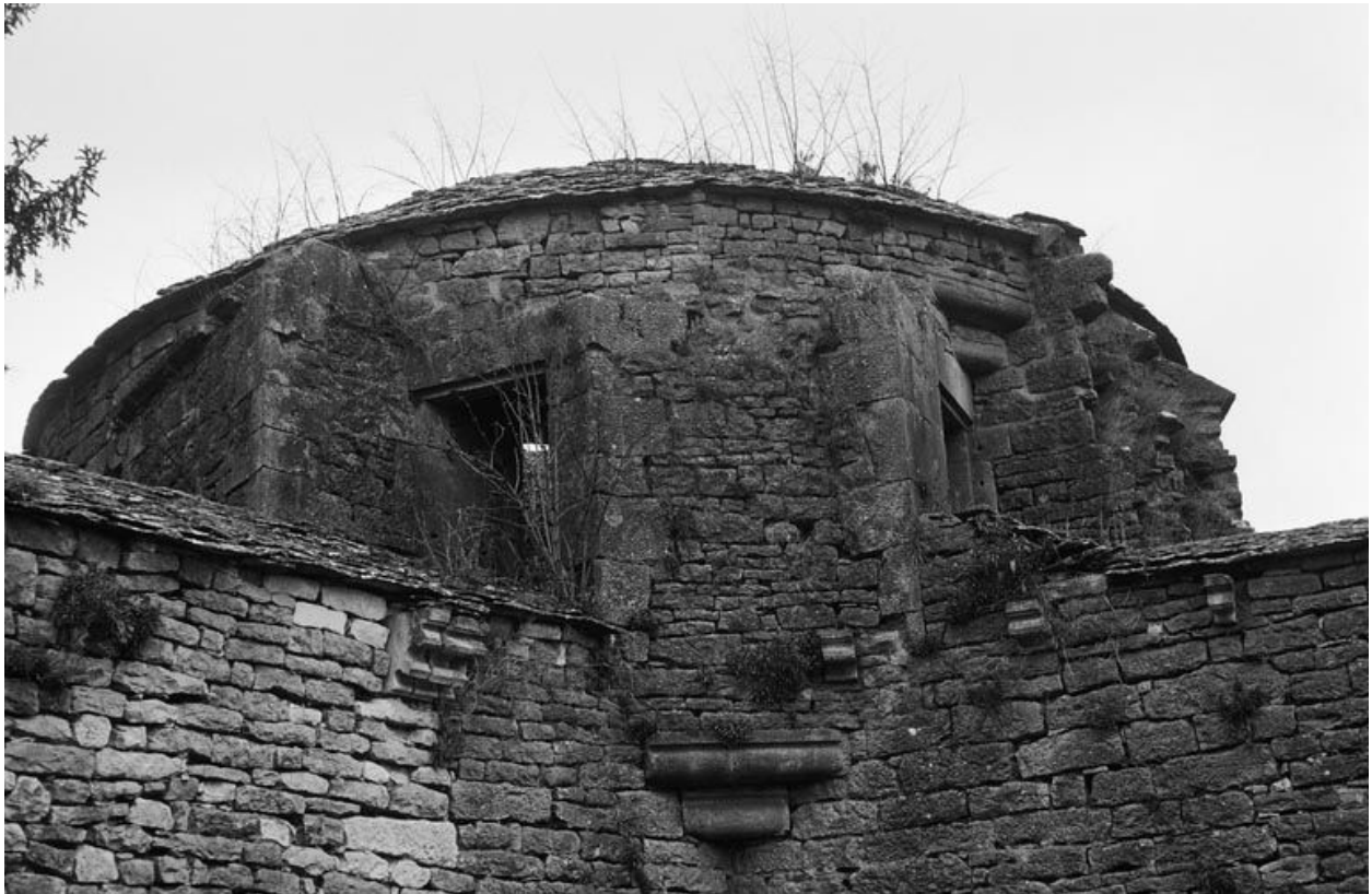
Enceinte : tour d'angle dominant le logis des Hôtes (photo prise en 1969).
