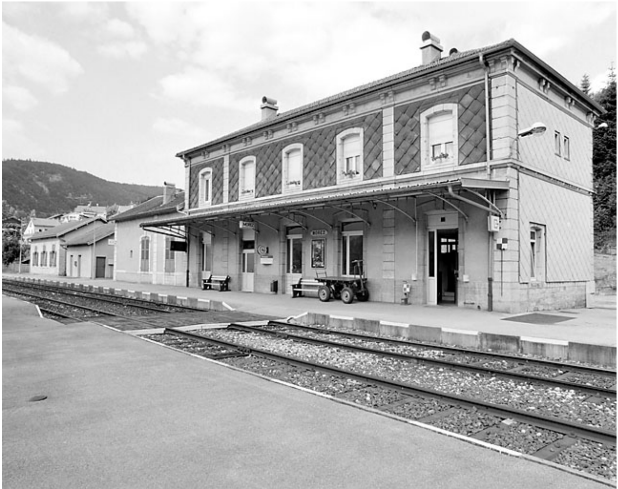
Bâtiment des voyageurs : façade postérieure, de trois quarts droite.
