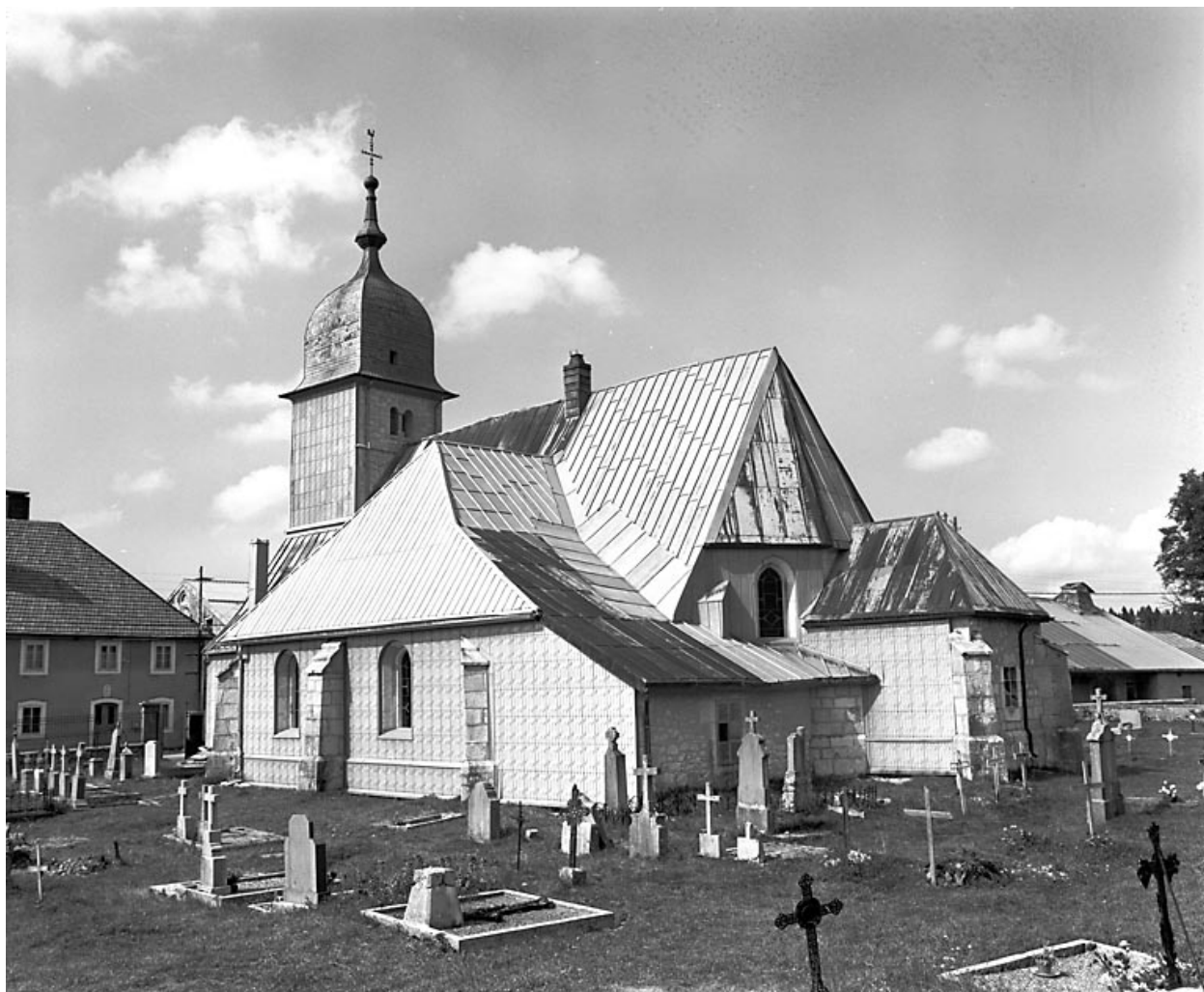
Façades postérieure et latérale droite.
