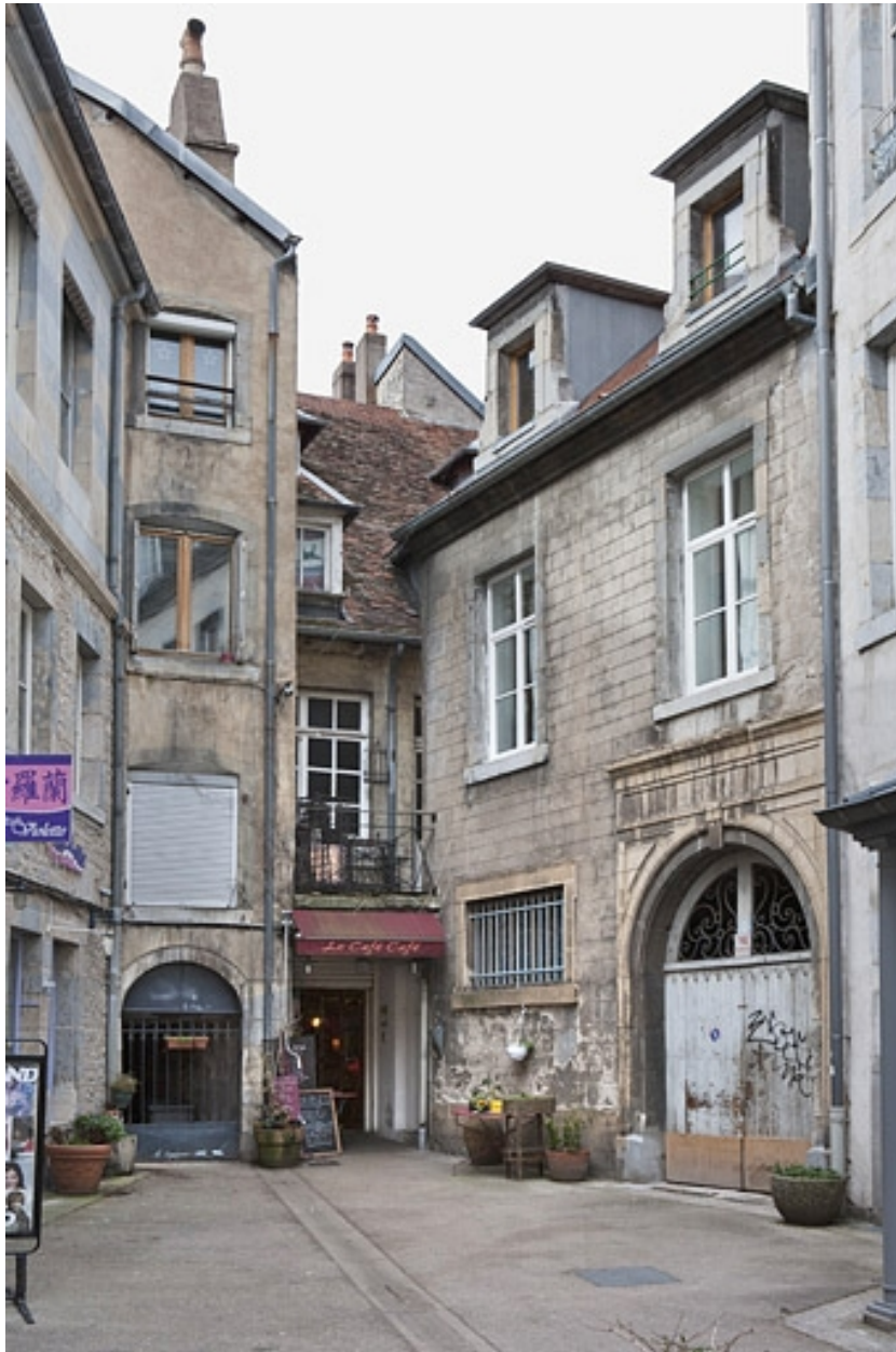
Façade postérieure des communs donnant sur l'impasse.
