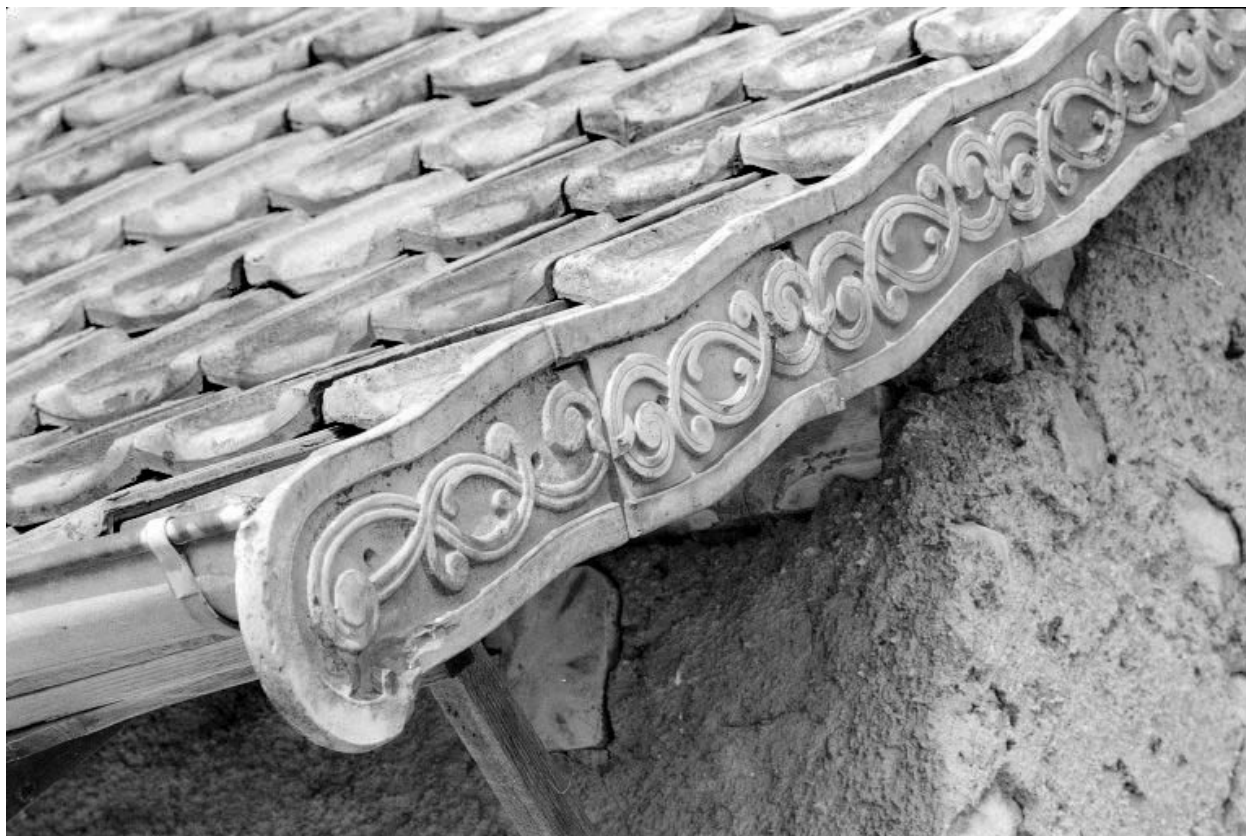
Montbouton, maison située 14 Grande Rue : détail du pignon droit de la remise.
