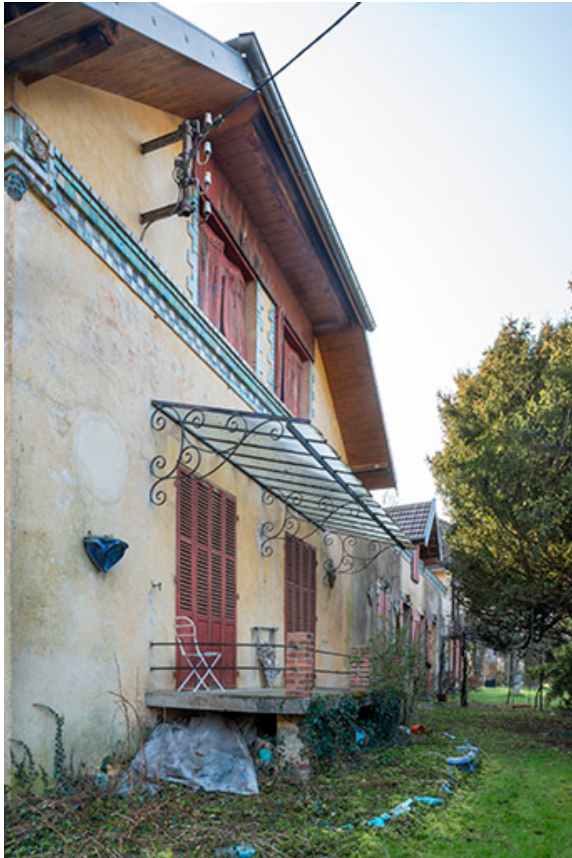
Vue de trois quarts des façades ouest.
