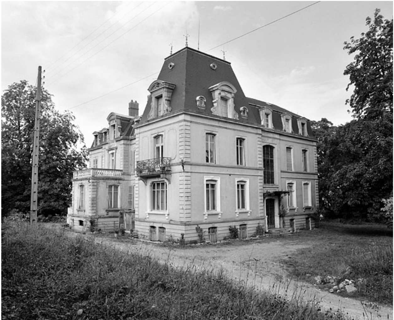
Vue de trois quarts en 1981.SRI. Enquête régionale sur les bâtiments industriels (1979-1981).
