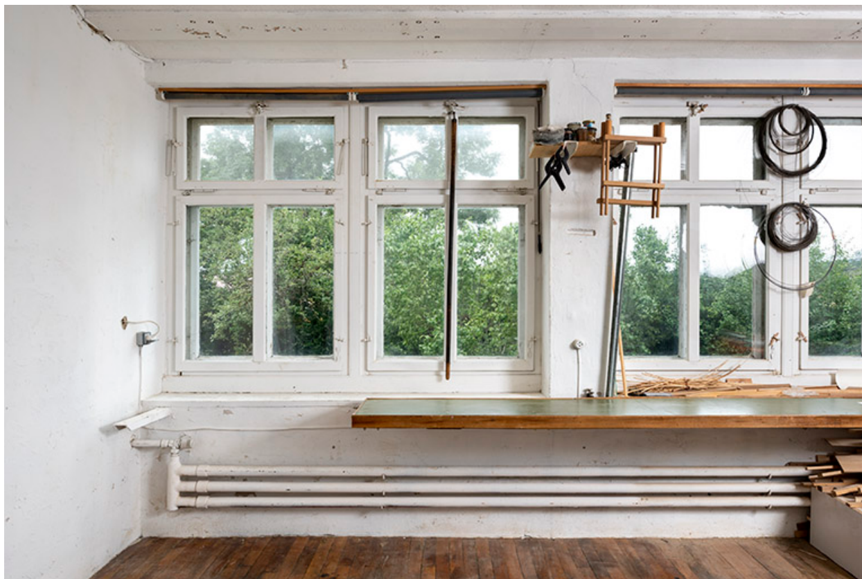
Usine, atelier : fenêtres horlogères, établi et chauffage.
