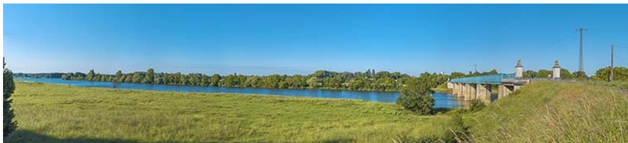
Le pont, vu d'aval.
