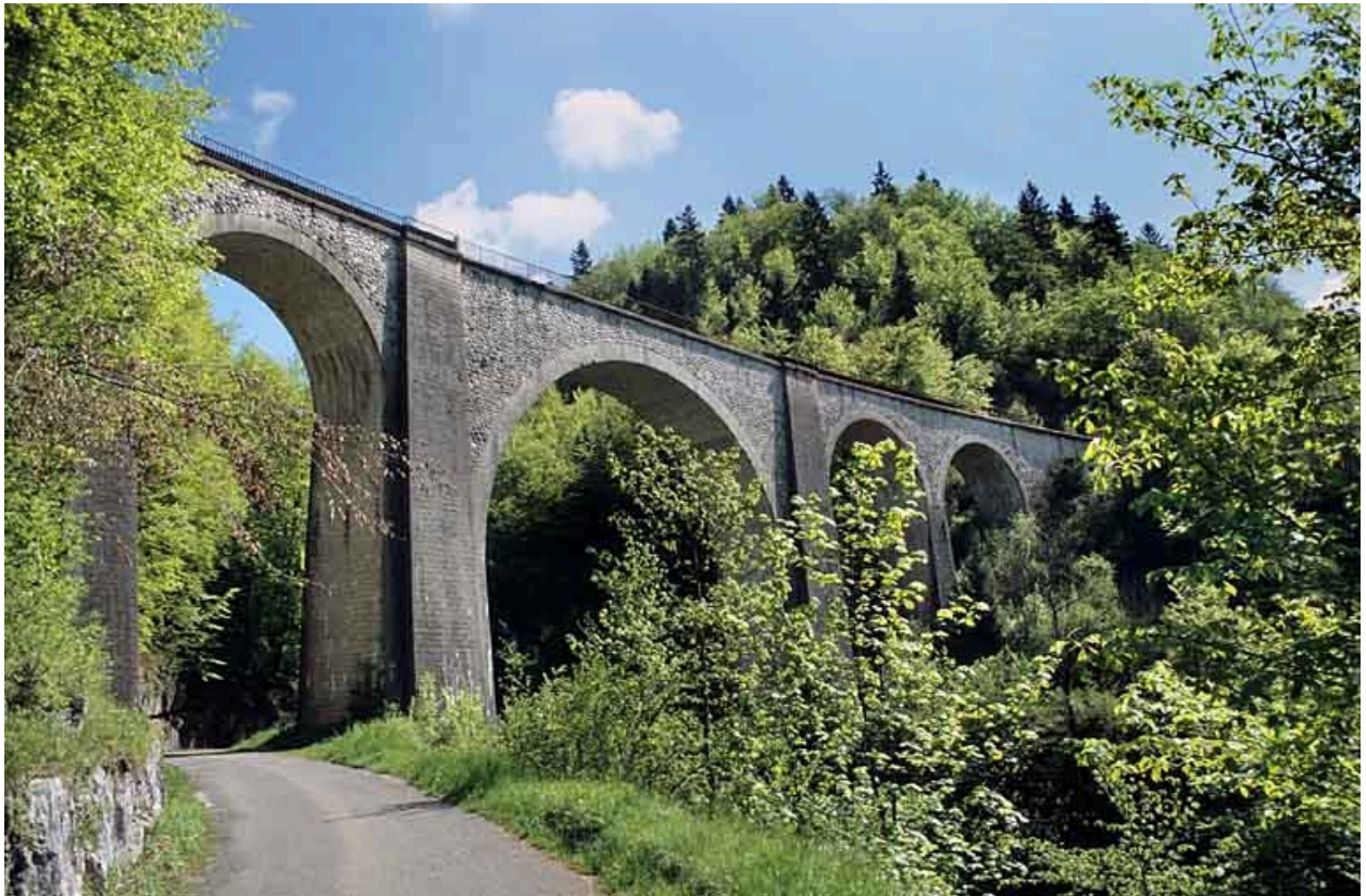
Elévation sud (aval), vue de trois quarts gauche.
