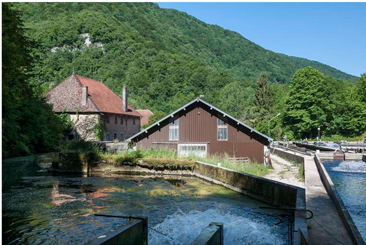
Vue depuis l'emplacement du bassin de retenue.
