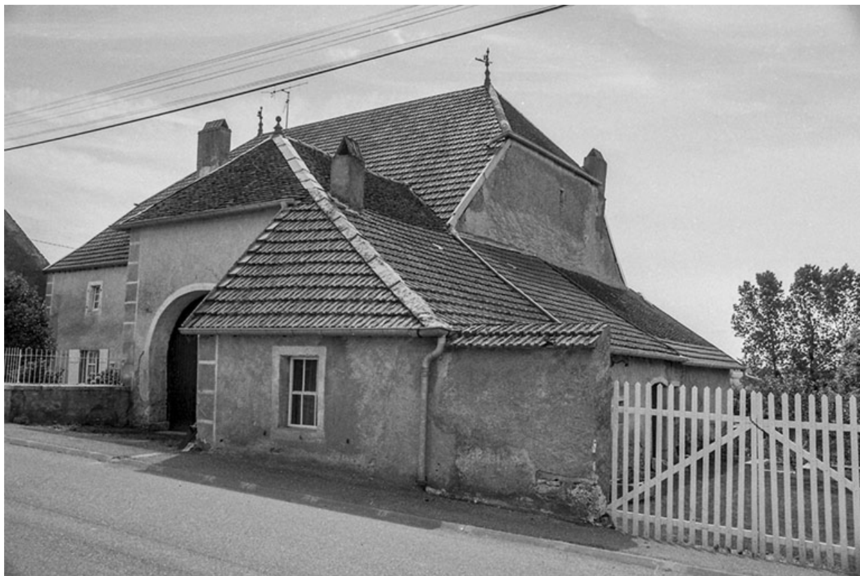
Façade antérieure et latérale droite.
