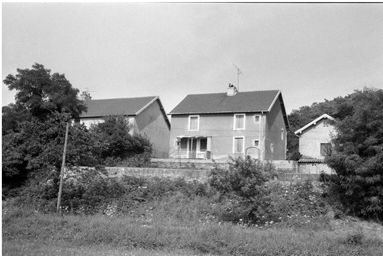
Façade postérieure de la "Caserne" (A, B).
