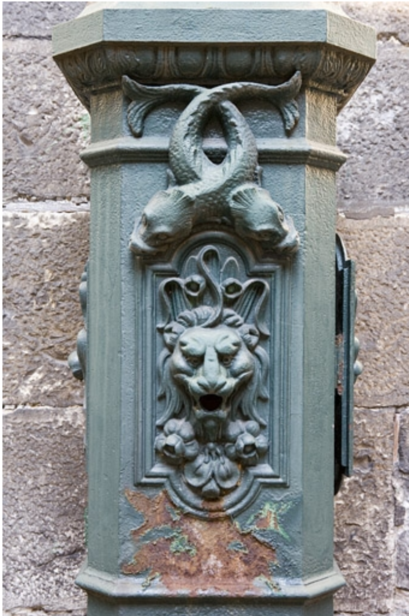
Détail de la partie centrale de la borne fontaine.
