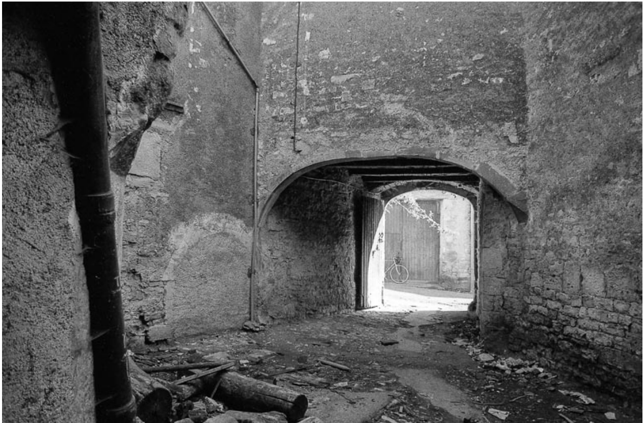
Vue du porche depuis la cour.
