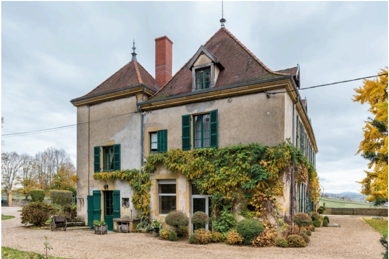
Façade latérale ouest du château
