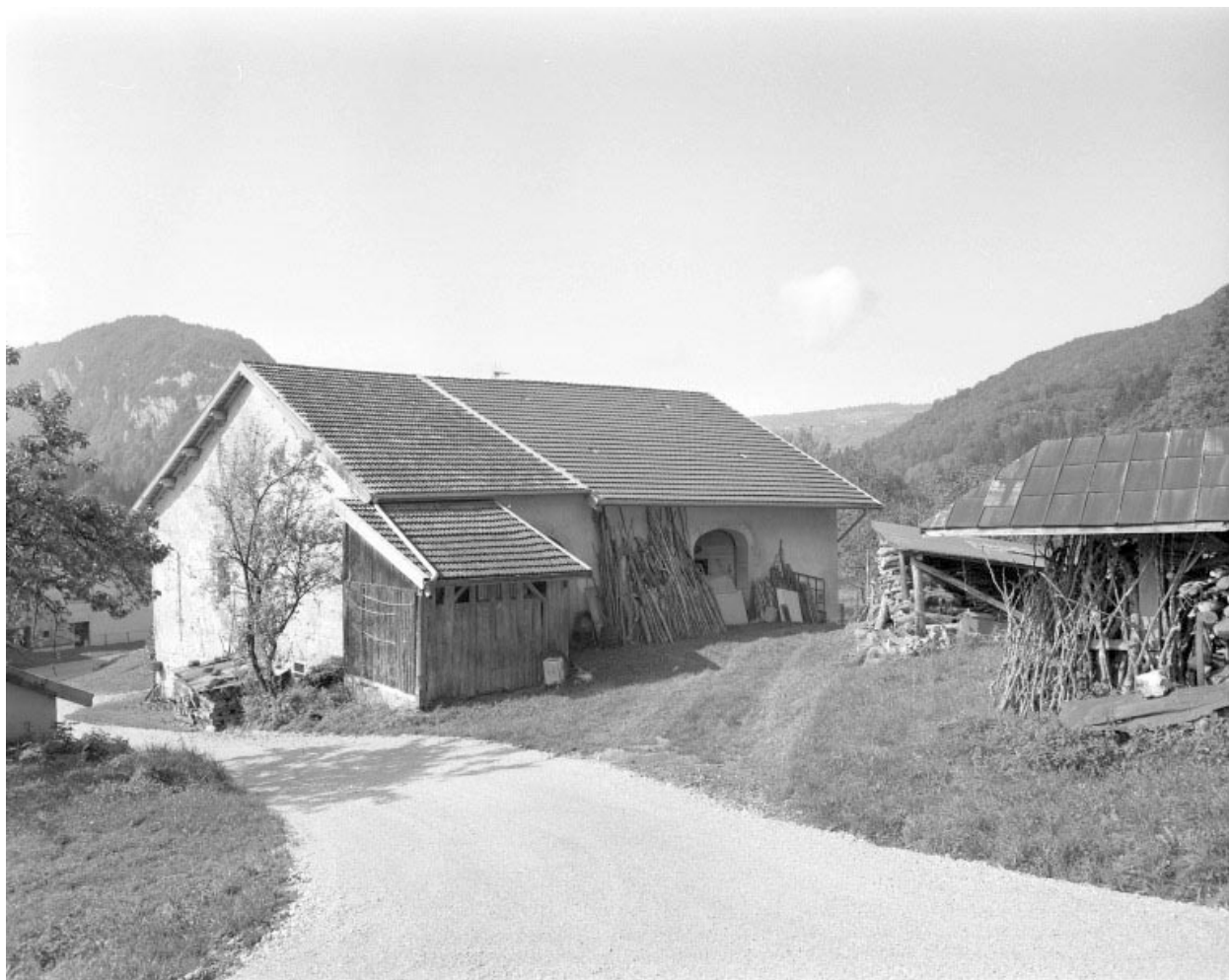
Vue générale de la façade postérieure.
