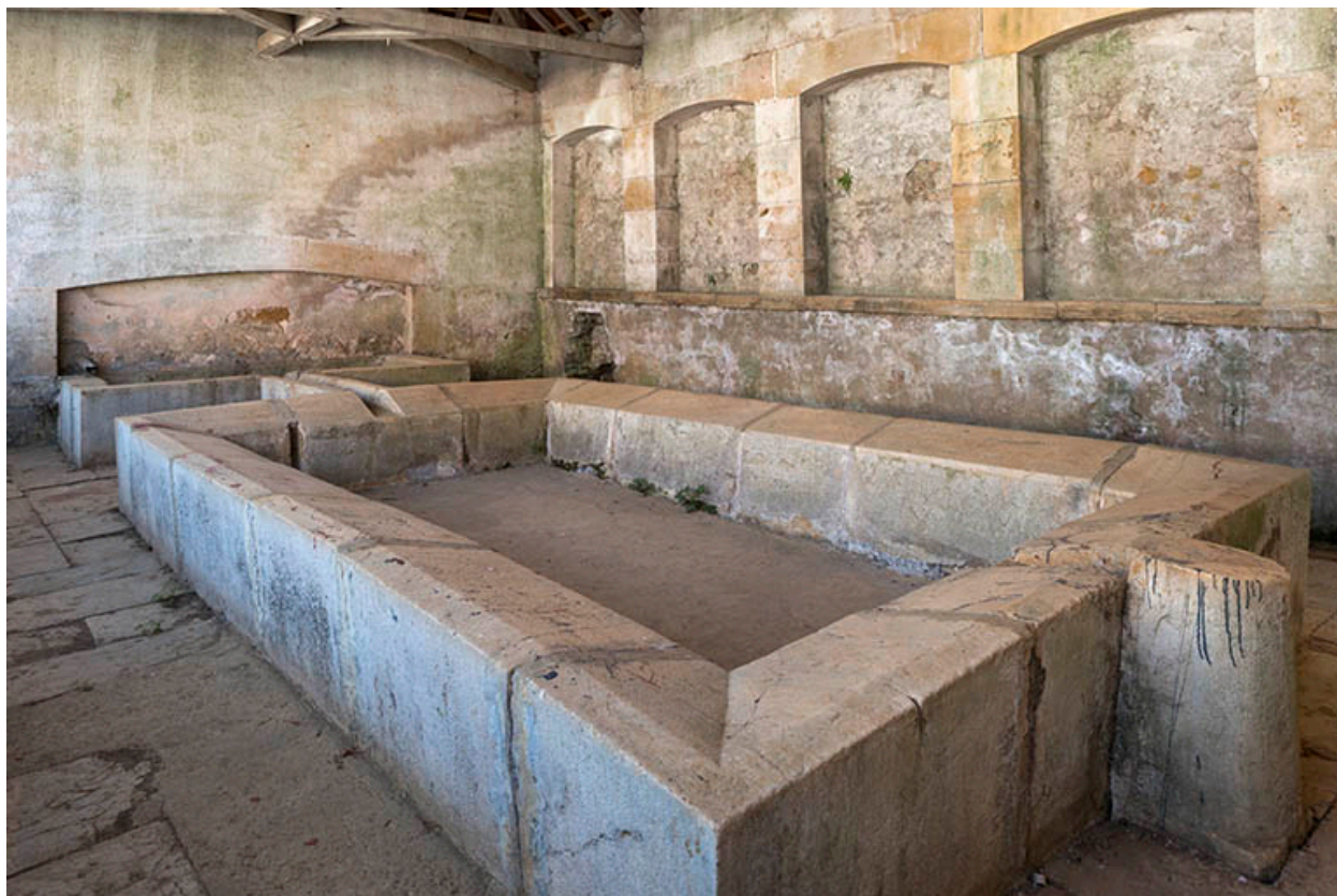
Le bassin du lavoir.
